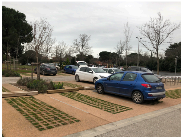
Exemple de stationnements avec dalles alvéolaires végétalisées et espaces de pleine terre
