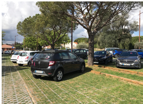
Exemple de stationnements avec dalles alvéolaires végétalisées et espaces de pleine terre
