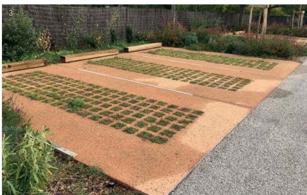
(1) Ecoulements pluviaux guidés vers un sol poreux à Aubagne (© Agam)
