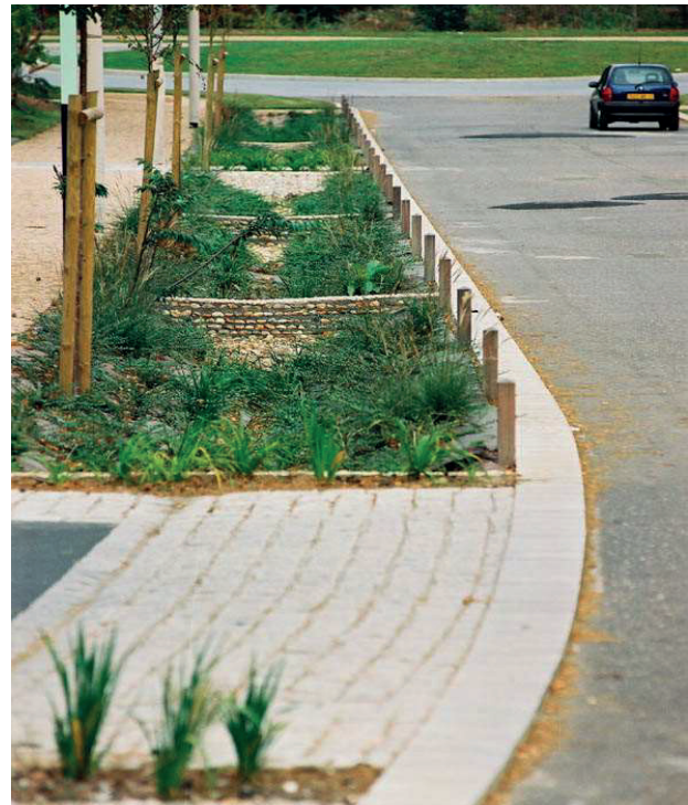
Noie à redents, technopole du Madrillet à Saint-Etienne de Rouvray (© Infra Service)
