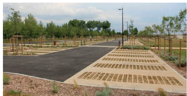
(1) Parking en dalles perméables végétalisées à Fréjus (© O2D) (2) Parc d'activités du Rovaltain, Valence (© Rovaltain.fr)
