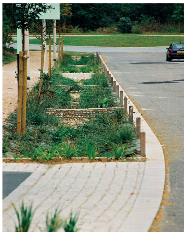
Noe à redents, technopole du Madrillet à Saint-Etienne de Rouvray (© Infra Service)
