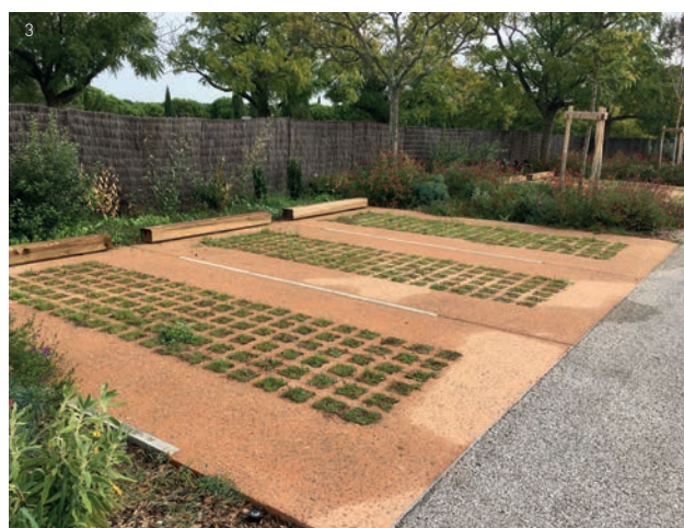
(1) Ecoulements pluviaux guidés vers un sol poreux à Aubagne (© Agam) (2) Dalles alvéolées en béton coulé en place et remplies de granulats à Marseille (© Via Verde) - (3) Combinaison de revêtement perméable et massif drainant à Montpellier (© Via Verde)
