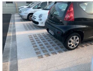
(1) Dalles alvéolées en béton coulé en place et remplies de granulats à Marseille (© Via Verde) (2) Ecoulements pluviaux guidés vers un sol poreux à Aubagne (© Agam)
