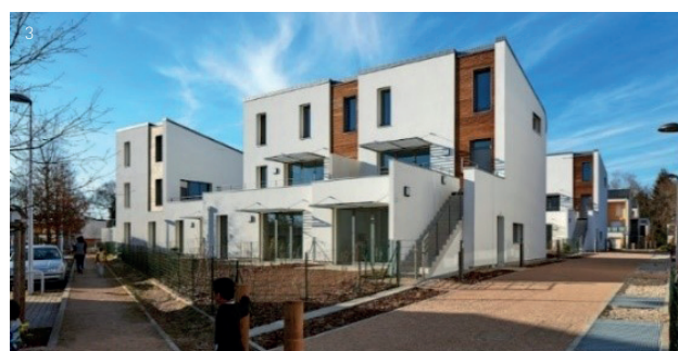
(1) Noue de stockage dans un lotissement, Les Clayes sous Bois (© ATM)
