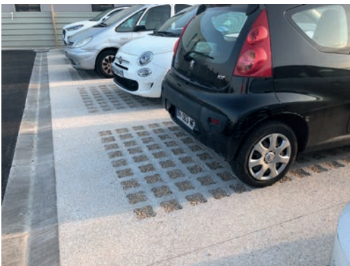
[1] Dalles alvéolées en béton coulé en place et remplies de granulats à Marseille [© Via Sols] [2] Ecoulements pluviaux guidés vers un sol poreux à Aubagne [© Agam]
