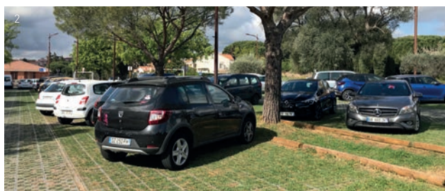
[1] Parc d'activités du Rovaltain, Valence (© Rovaltain.fr) [2] Parking en dalles perméables végétalisées à Fréjus (© O2D)
