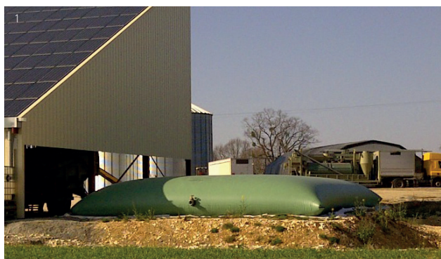
[1] [2] Citerne souple de grand volume raccordée en toiture d'un bâtiment agricole (© RCY)
