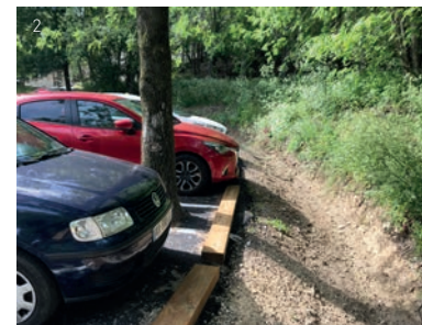
(1) Dalles alvéolées en béton coulé en place et remplies de granulats à Marseille (© Via Verde) (2) Ecoulements pluviaux guidés vers un sol poreux à Aubagne (© Agam)
